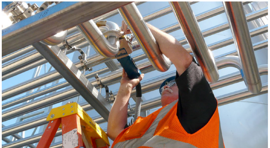
▲ Bild 2. Im Laufe der Entwicklung sind Orbitalschweißköpfe immer kompakter geworden und ermöglichen daher sichere Schweißungen selbst unter beengten Platzverhältnissen.
