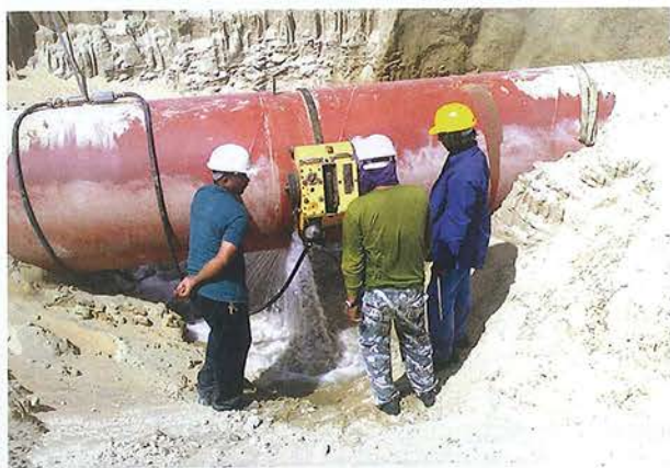
TAGLIO ORIZZONTALE E VERTICALE CON SISTEMI E.H. WACHS
